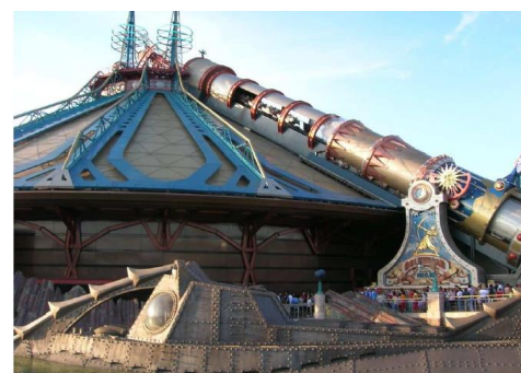
Bâtiment vu de l'extérieur
